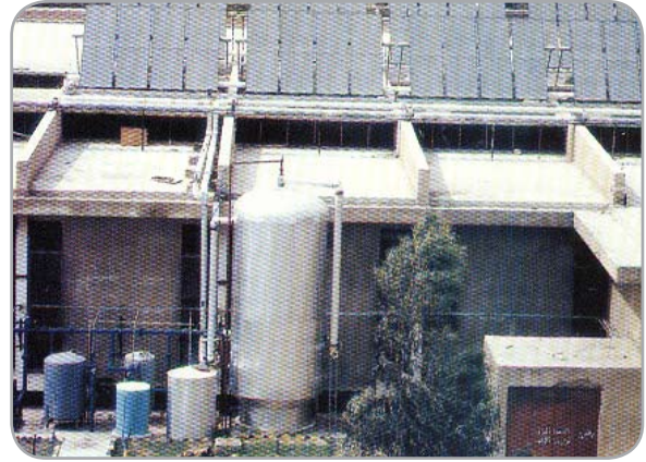
التسخين الشمسي الحرارى واستعادة الحرارة المفقودة (المجزر الألى مصر الجديدة) تاريخ بدء التشغيل : ١٩٩٠
